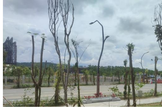
Kondisi jalan sumbu kebangsaan
