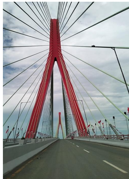
Jembatan pulau balang
