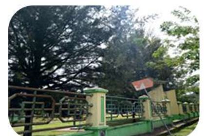
Rambu evakuasi di Painan yang arahnya telah berubah sehingga perlu dilakukan perawatan
