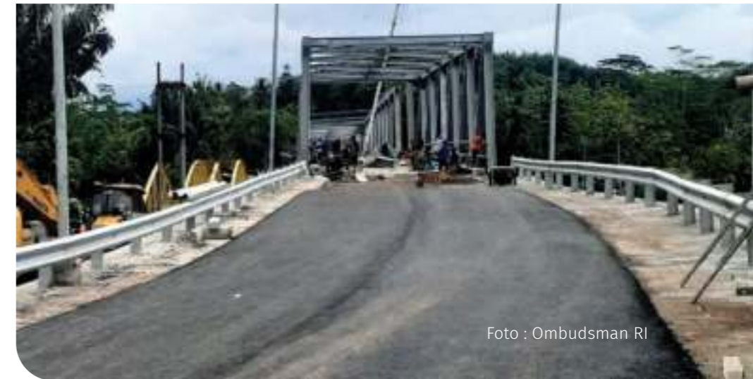
Proses pembangunan jembatan baru Cibuni
